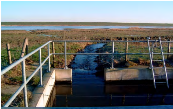
Figuur 25: Geheel zoete vrij verval vispassage op zoet-zout overgang; Breebaart Waterschap Hunze en Aa's
