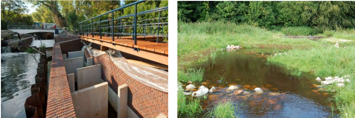
Figuur 30: Links, voorbeeld verticale schotten vistrap bij de Mgr. Wilmerstraat, Dommel, rechts vistrap van Dickinge, Reestdal
