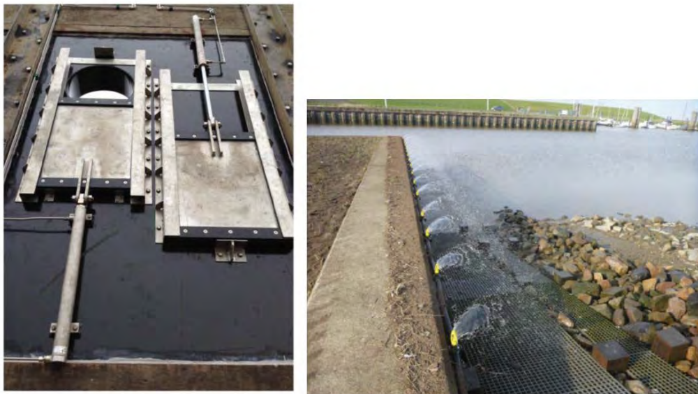
Figuur 27: Links een voorbeeld van kattenluiken, rechts een voorbeeld van een aalgoot (foto's: Hunze en Aa's)
