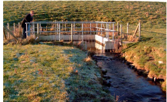
Figuur 25: Geheel zoete vrij verval vispassage op zoet-zout overgang; Breebaart Waterschap Hunze en Aa's
