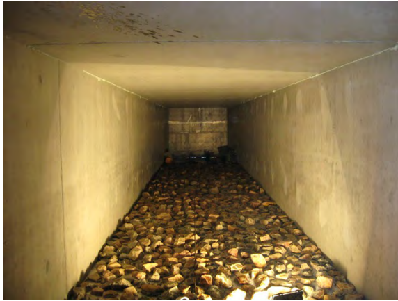
Figuur 26: Voorbeeld duiker met substraat, Waterschap Aa en Maas vispassage Crèvecoeur
