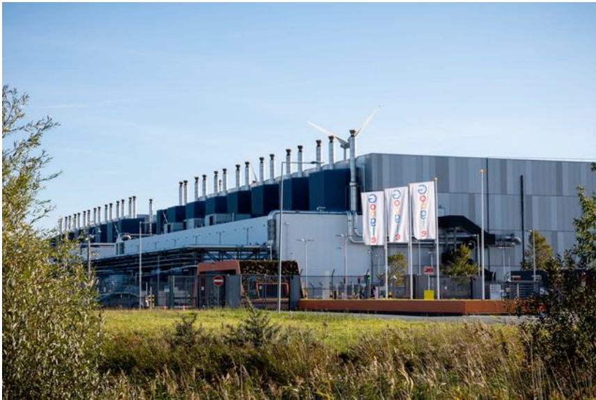
Het datacenter van Greenbox in de Eemshaven. Foto DvhN
